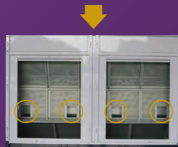
点検窓を開いた状態
