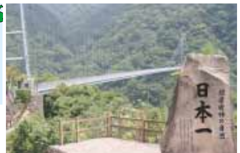
「綾照葉大吊橋」が町のシンボル。
